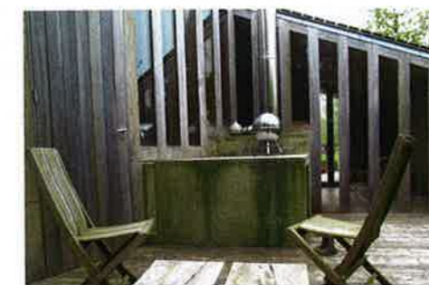
Het huis en terras aan de achterzijde. Hier is het hout al aardig grijs verkleurd.
